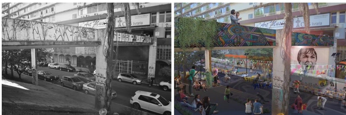
FIGURA 3 – Antes e depois: intervenção na rua de serviço do Conic. Foto: Eduarda Aun
